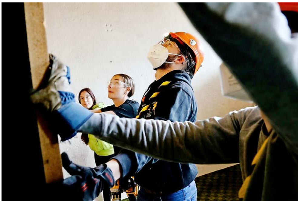
Bei der Renovation des ehemaligen Konsums packen auch die Pfadfinder tatkräftig mit an.
